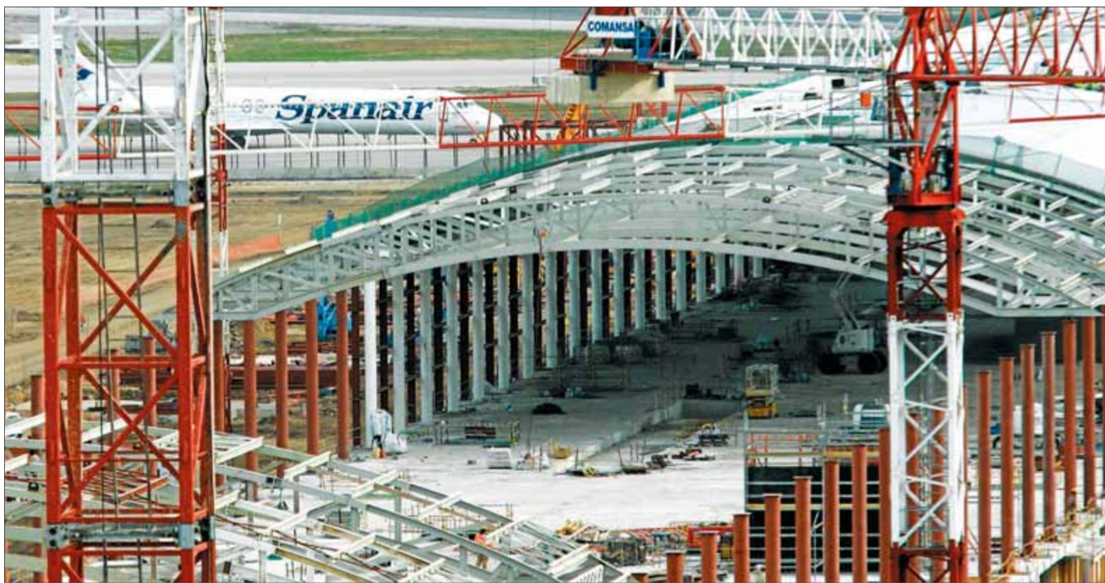
Una imatge de la nova terminal que s'està fent a l'aeroport de Barcelona ■ MIQUEL ANGLARILL
